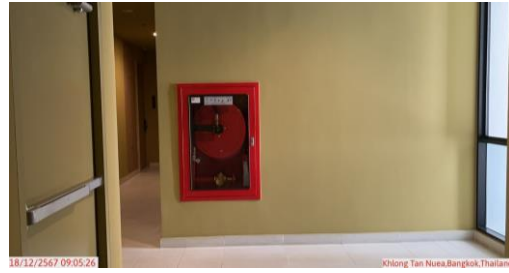
ตู้สายฉีดน้ำดับเพลิงพร้อมอุปกรณ์
